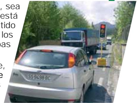
Para destacar la presencia de los límites de las obras y las ordenaciones de la circulación a que den lugar se utilizan **señales de balizamiento** fácilmente perceptibles por el conductor.
